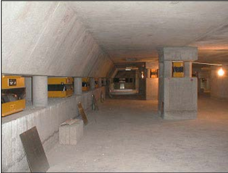
GPNV-Elemente unter einem Fernsehstudio (mit temporären Stützen im Bauzustand)
