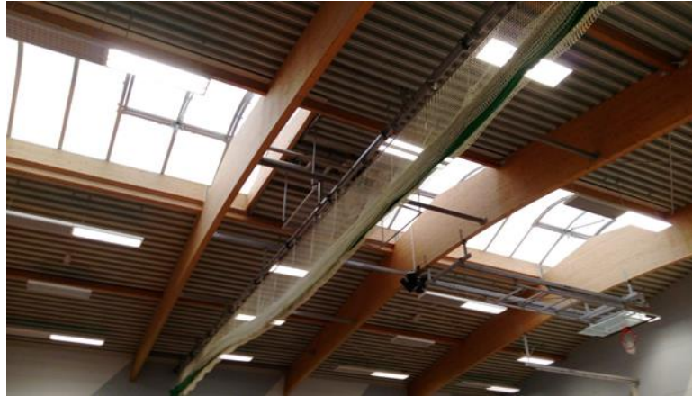
Abbildung 9: Hallendecke mit Querbalken und Kunstglaskuppel
