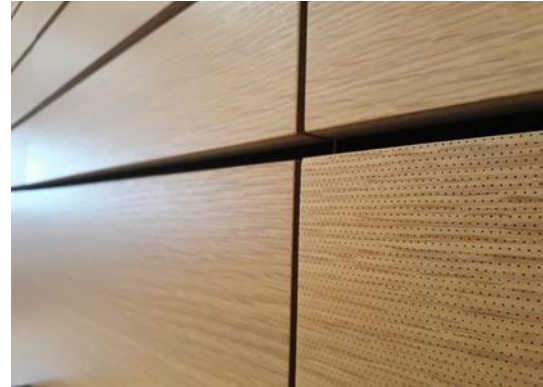
Abbildung 7: Holzvertäfelung mit Lochplatten
